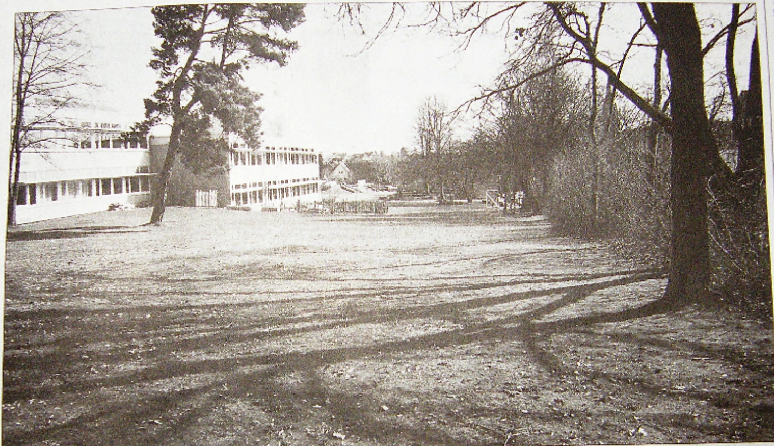
Auf dem Schulgelände in Villingendorf wird eine Sportanlage gebaut, wenn auch in abgespeckter Version.
